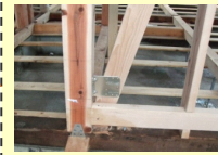
耐震補強工事の例
