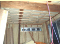
外壁断熱工事の例
