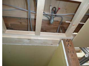
色の濃い所が既存部材、色の薄い所が入替・追加した部材
