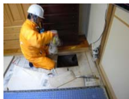
・床下の状況確認
