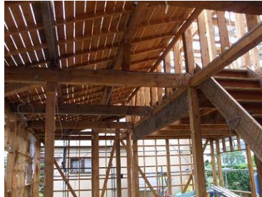
既存の基礎、柱、小屋組等を、出きる限り残す形の解体
